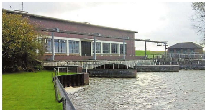
Über das Ellenserdammer Tief mit dem Dangaster Tief fließt alles Wasser aus dem Verbandsgebiet zum Schöpfwerk Petershorn (Foto) und weiter nach Dangast.
